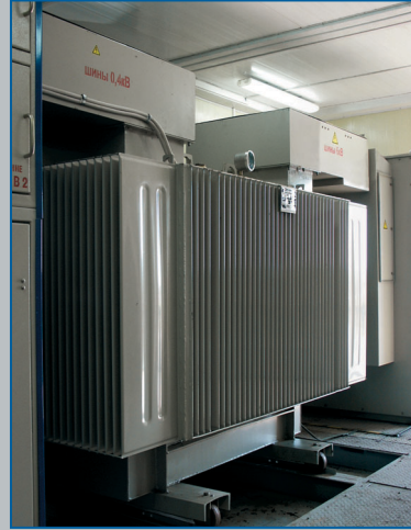
ТМГФ-СЭЩ® в составе KTP промышленного типа
